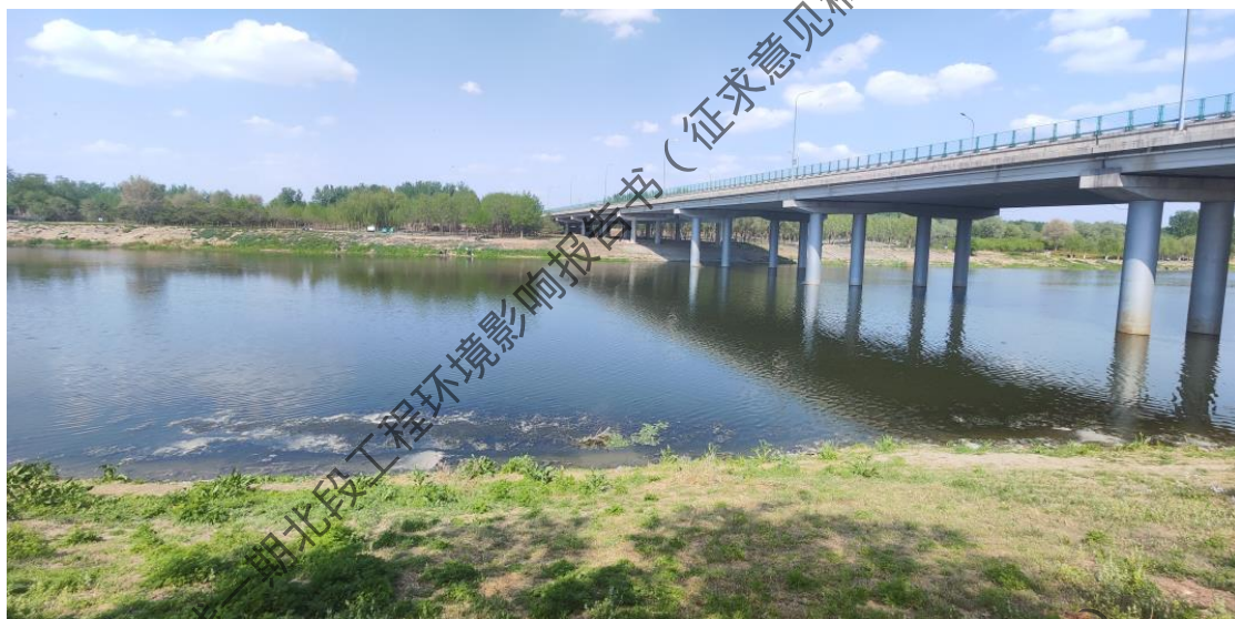
图 6.4-1 区间上跨温榆河跨越点现场图
