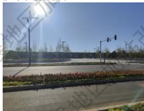
首都国际会展中心站附近现状轨道桥
